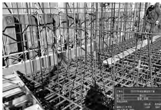
写真-4 導入例1 配筋検査ARシステム
