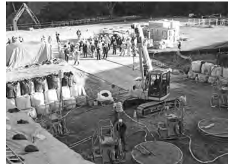
現場研修内薬液注入状況の見学の様子
