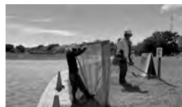
高水敷除草工実施状況
