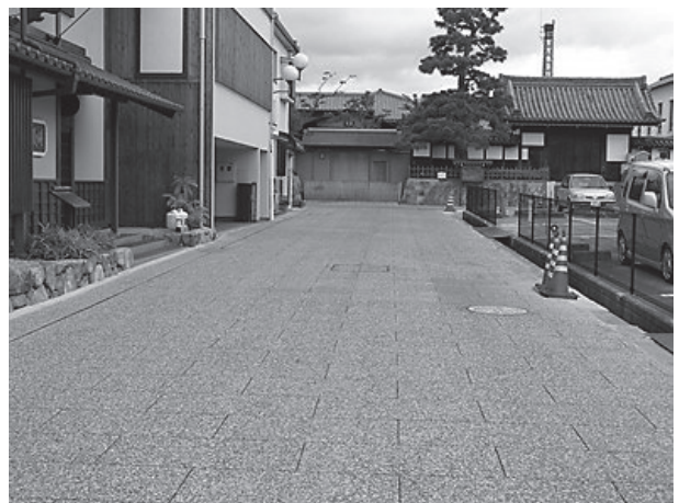
写真1 石畳風の半たわみ性舗装
