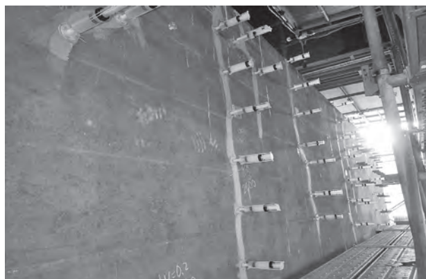
写真1 小規模工事（ひび割れ補修）
