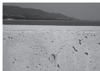
b) 沈みひび割れの例 写真 施工時に生じやすい不具合事例 1)
