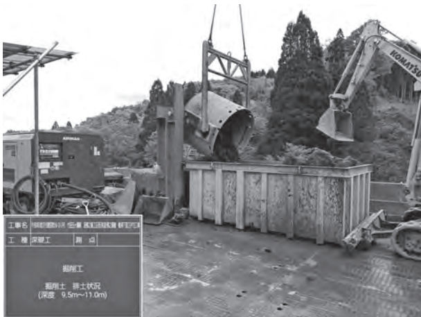
写真-10 大型排土バケットの開閉治具
