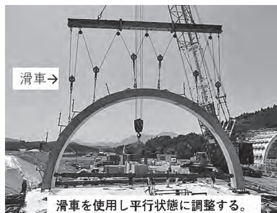
図-4 アーチ部吊上げ状況
