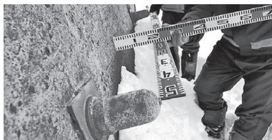
図-4 擁壁のアンカーキャップ
