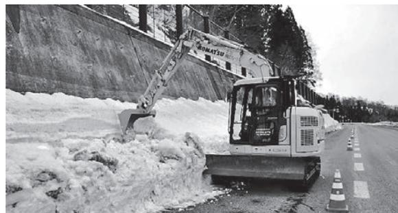
図-5 ICTバックホウ作業状況
