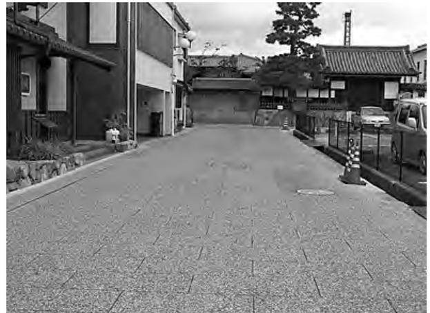
写真1 石畳風の半たわみ性舗装
