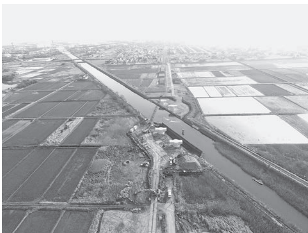
工事現場全体 (写真①)
