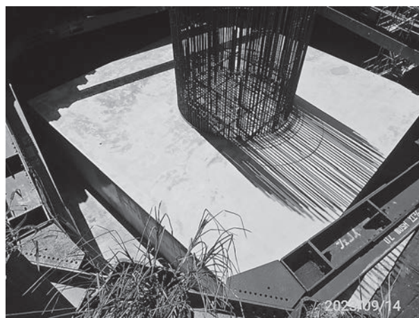
橋脚（フーチング部）施工状況（写真④）
