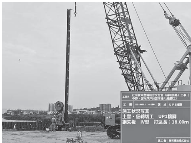
継手無し鋼矢板による土留・締切りの施工状況（写真②）
