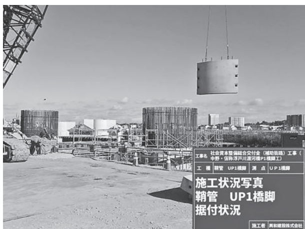
プレキャスト製の鞘管据付状況（写真③）
