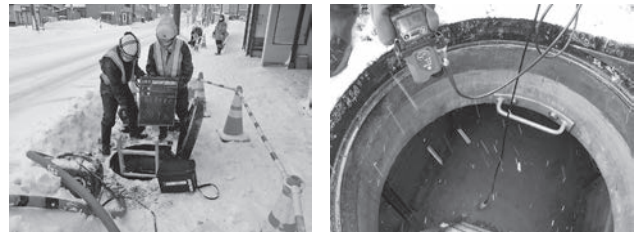
写真－７ 有毒ガス濃度等の測定
