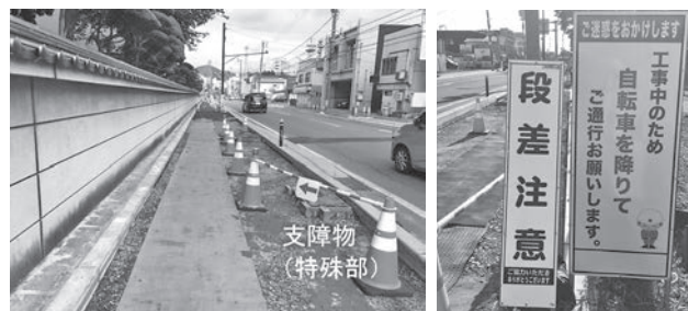
写真-2 ゴムマット敷設及び注意喚起看板
