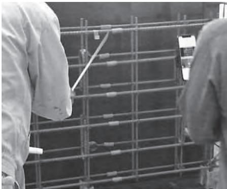
写真-7 鉄筋種類ごとにマーカーを設置
