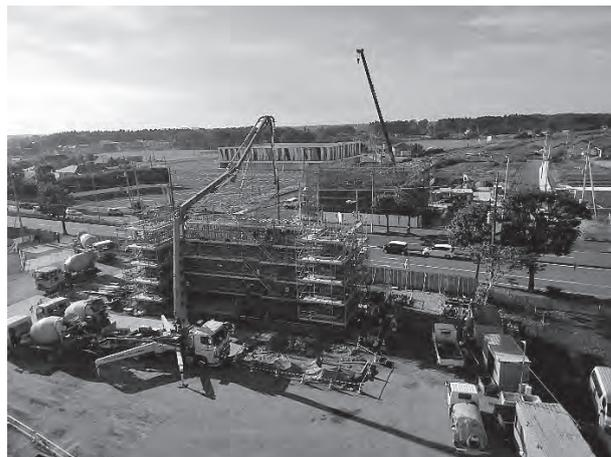
写真-3 橋梁下部工を施工
