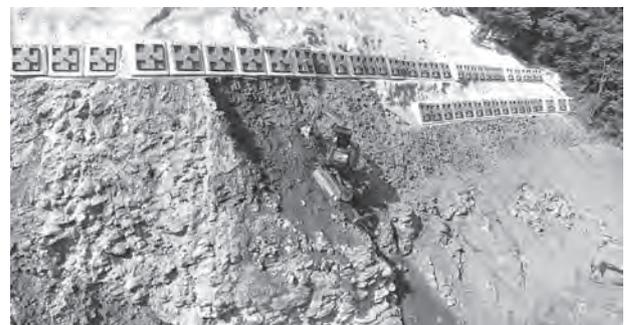
図-7 MGシステムによる法面掘削
