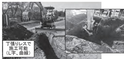
写真2 小規模土工（掘削）検証状況（L字掘削）
