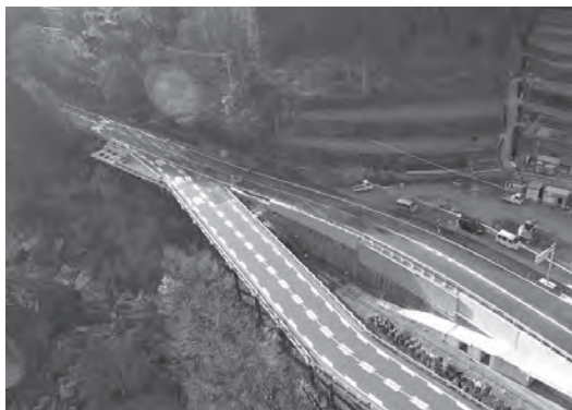
新設アクセス道路区間に接合された迂回路終点端部
