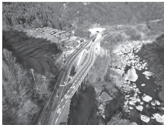
2020年 橋中津トンネル供用開始前
