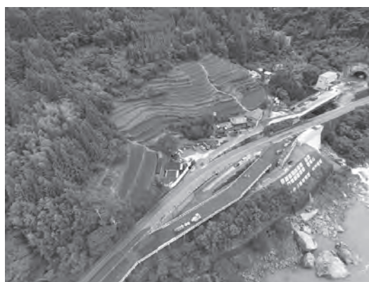
2018：迂回路設置状況
