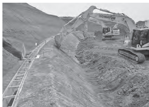
図－8 ICT建機による凹部のカーブ掘削
