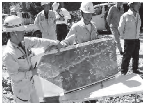
道路災害現場（法面对策工）県の工法説明
