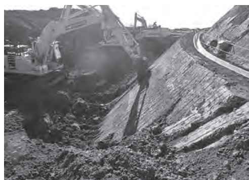
図－7 ICT建機による凸部のカーブ掘削
