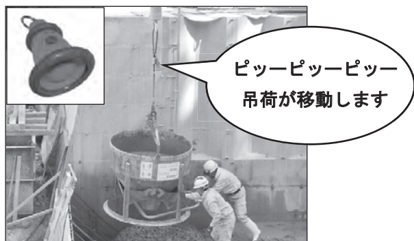
図-12 吊荷警報器取付作業状況
