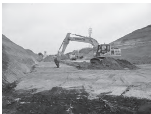
図－6 ICT建機による床付作業
