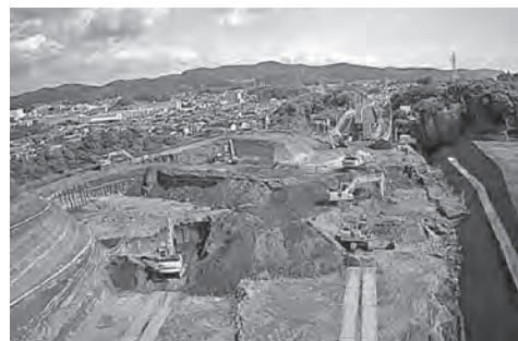
図-4 7台体制での施工
