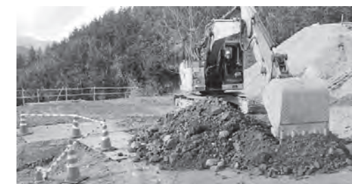
図-14 ロードマット・山砂利敷設
