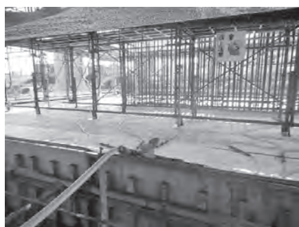
図-10 湛水養生状況
