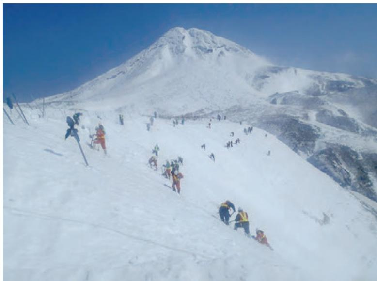
知床峠開通に向けて、崩雪防止対策のため雪庇を人力で切り落としています。
