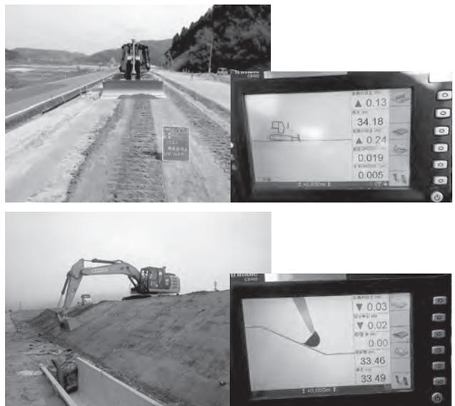
図-5 ICT建機による作業状況
