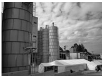
相双地区生コン製造工場完成
