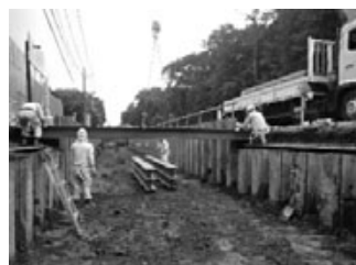
図-12 覆工板設置
