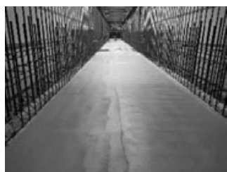
図-6 外型枠状況
