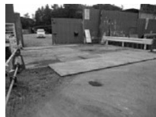
図-13 覆工板設置完了
