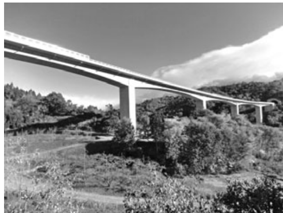
復興支援道路 相馬福島道路・月舘高架橋
