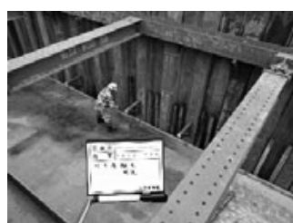
図-9 砂詰め（水締め）
