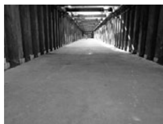
図-7 構造物構築
