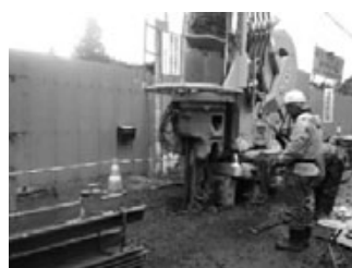
図-10 鋼矢板圧入
