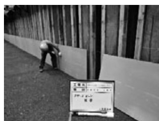
図-5 ゼロスペースボード設置
