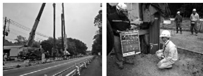
図-3 先行掘削圧入状況
