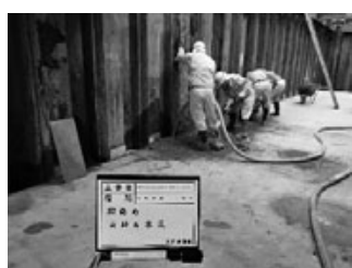
図-8 支持材撤去（端太角）
