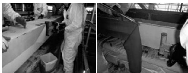
図-3 電磁誘導加熱工法
