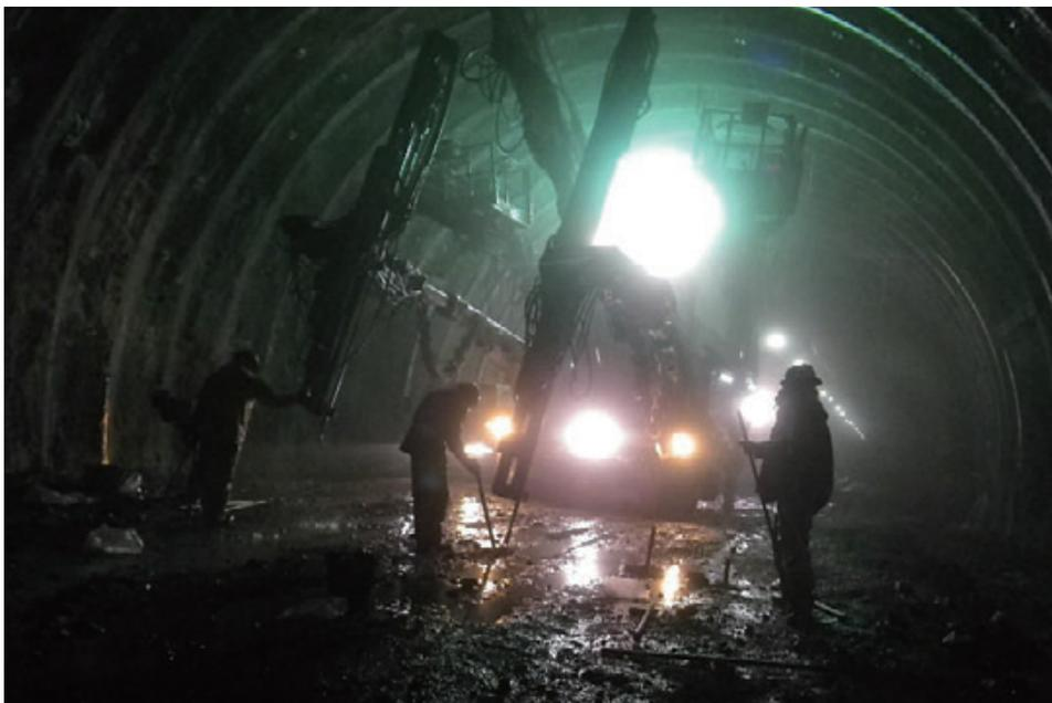
トンネル前方ではなく、底盤部の削孔作業状況を撮影。地味だが重要な作業の様子を、光と影のコントラストで表現した。(鹿児島県内 道路トンネル工事現場にて撮影)
