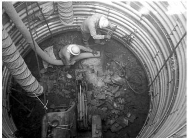
図3 砂岩中央部にセリ矢が数本打ち込まれている
