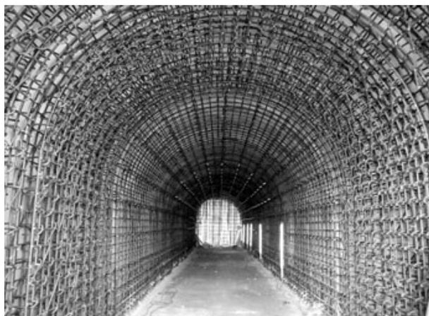
図6 シェルターの鉄筋写真
