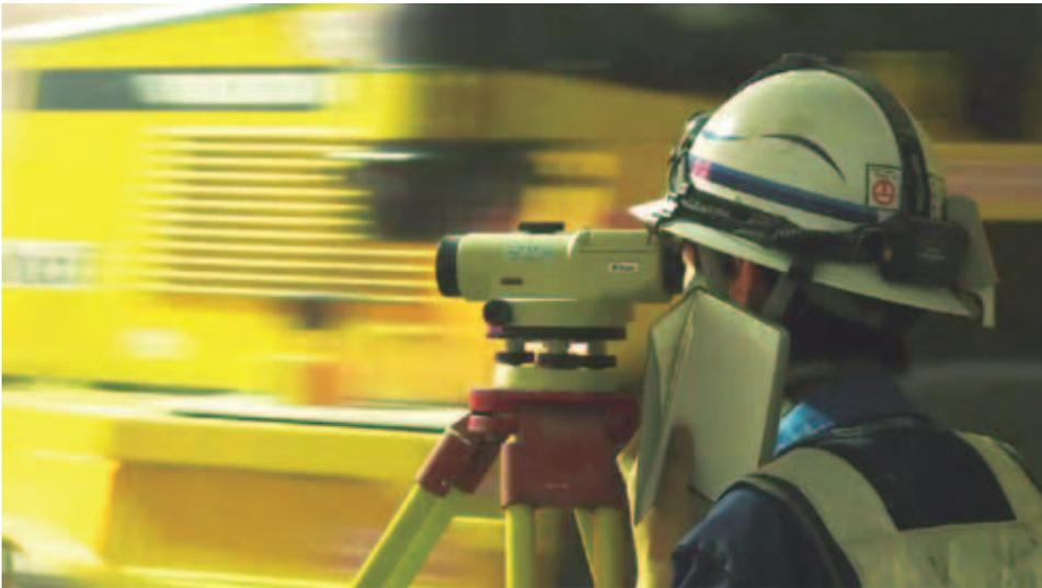
大型重機が往来する中、トンネルの覆工コンクリート用型枠（セントル）のセット測量をしています。ご安心ください、ガードされた位置で行っています。m( )m
