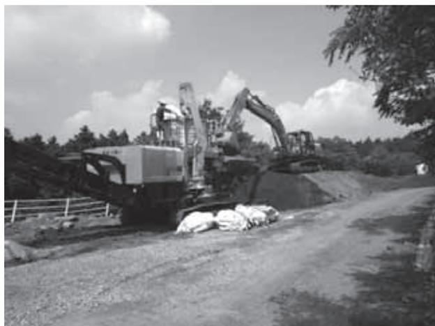
図-4 受入土(崩落土)改良状況
