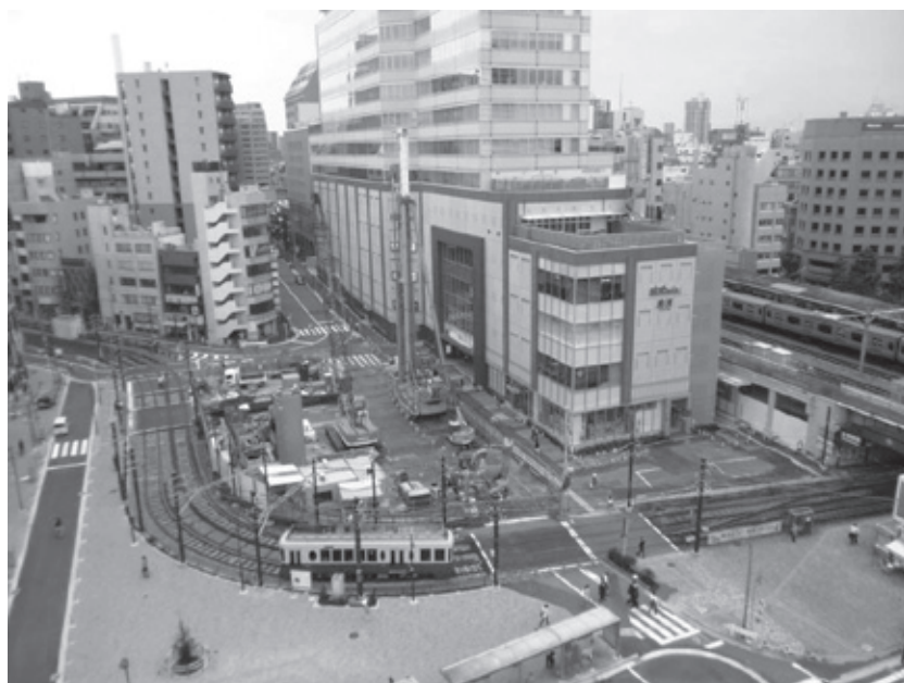
図-1 工事箇所全景写真
