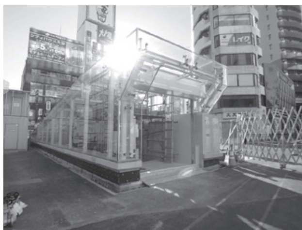
図-15 自転車駐車場出入口完成
