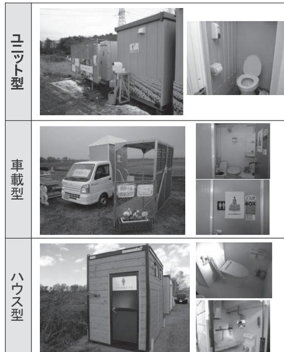
図-1 H27モデル工事において導入した仮設トイレのタイプ
