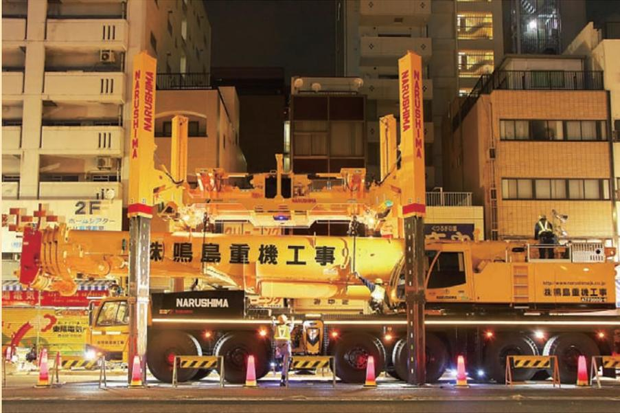
永代通りの夜間作業帯でリフターを使用しての大型クレーンの解体です。相判クレーン無しなので、狭いスペースで組立て・解体が出来ます。道路の反対側から撮影しましたが、クレーンが大きすぎて、画面に全体が入りきりませんでした。
