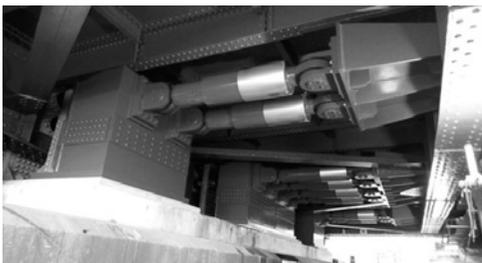
図-2 ダンパー設置完了
