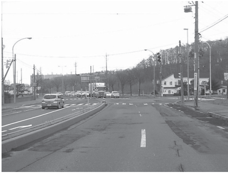
図-10 作業前L側 (2012.3)
