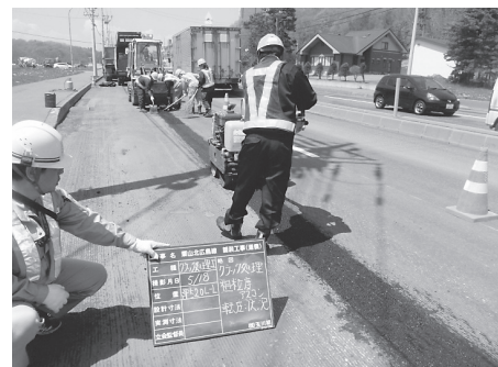
図-9 基層舗装状況
