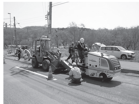
図-7 クラック部溝切削状況
