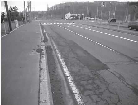
図-11 作業前R側 (2012.3)
