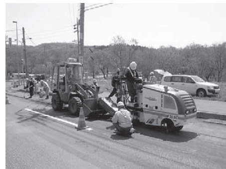
図－７ クラック部溝切削状況
