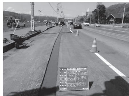
図－８ クラックシート設置状況
