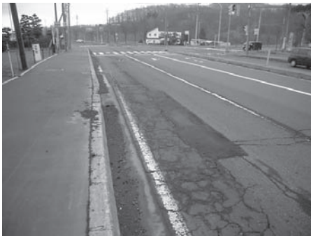
図-11 作業前R側 (2012.3)
