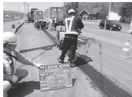
図－９ 基層舗装状況
