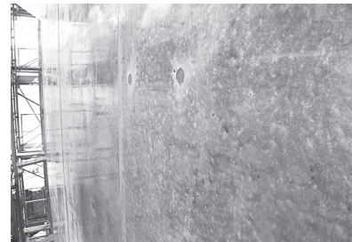
図-10 ガラス質が形成されたコンクリート表面
