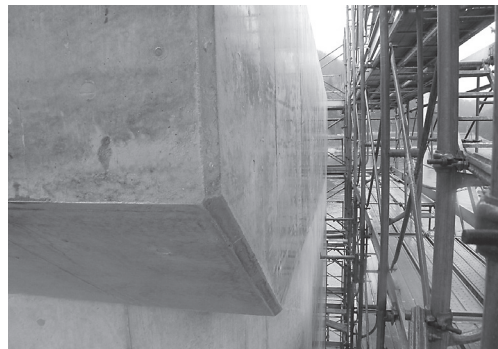
図-6 脱型後のコンクリート
