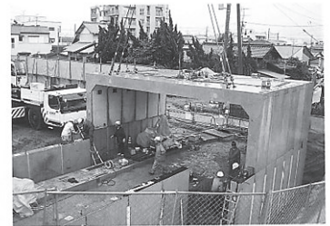
分割式による大型化(上下2分割式の例)
