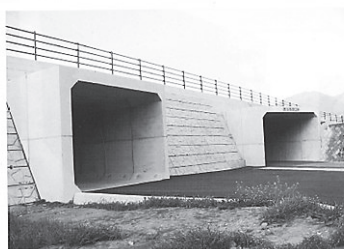
分割式による大型化(上下2分割式の例)
