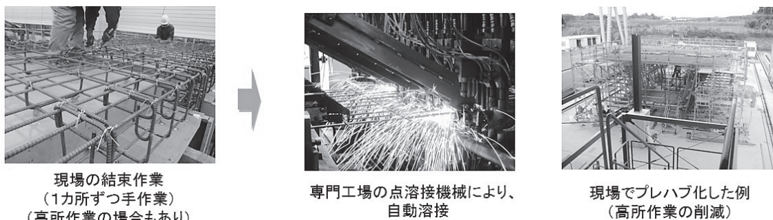
図－1 鉄筋のプレハブ化のイメージ
