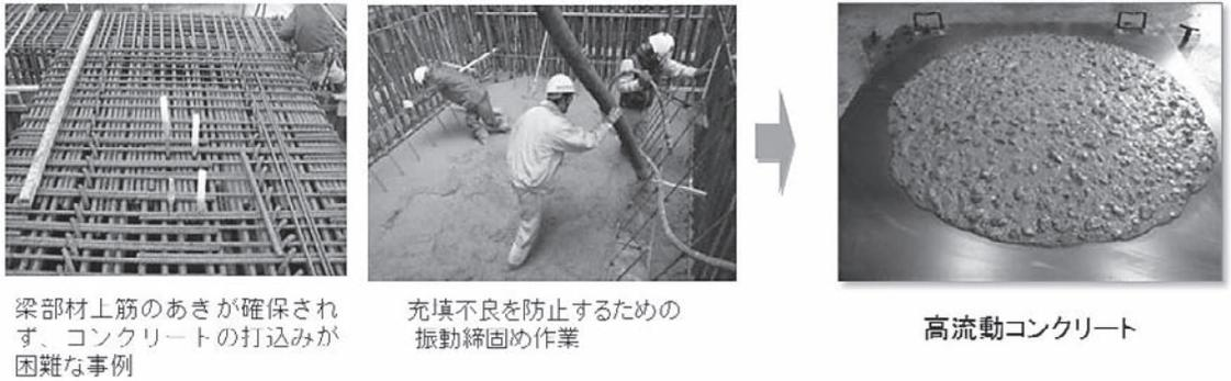
図-3 高流動コンクリートのイメージ
