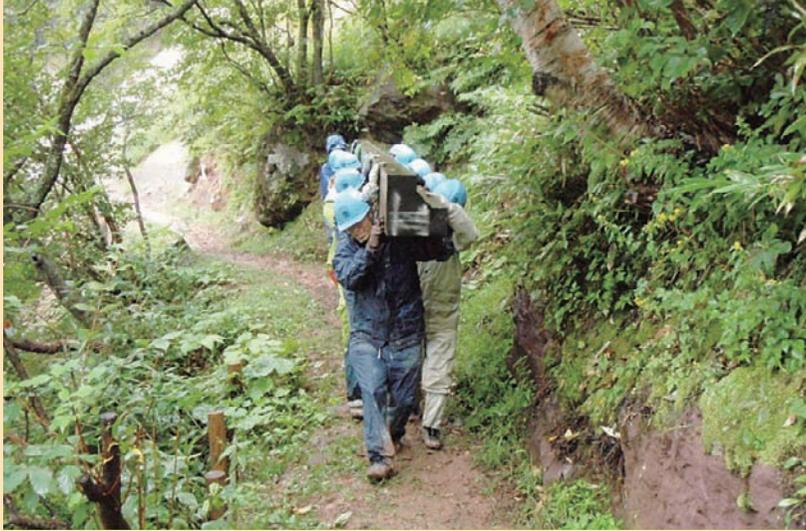
那須山の源泉を引いている温泉管が、土砂崩れによって現されたための防護管。1本物で6m。4ッ割りの1つが300Kg 超の物を、人力で運搬した時の1枚。
