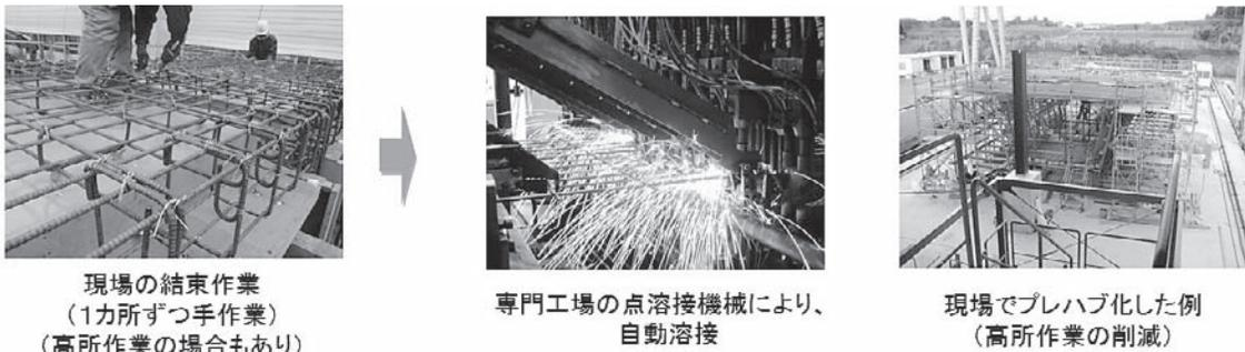
図-1 鉄筋のプレハブ化のイメージ
