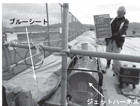
図-4 保温養生状況
