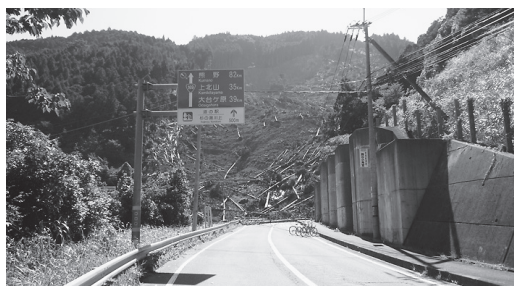
紀伊半島大水害被害現場 ※災害当時
