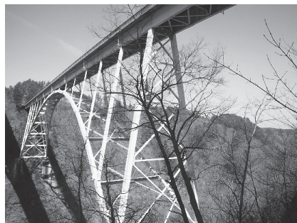
図-1 榎木沢橋全景(補修前)
