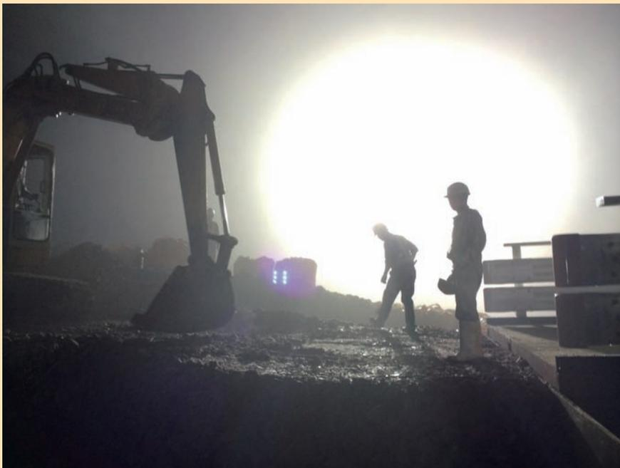
豪雨災害により橋梁が流失し孤立した集落のために仮設橋を架設する緊急復旧工事です。昼夜の作業を続け1週間で架設を完了することができました。照明車による光と夜霧により浮かび上がる使命感を持った作業員達です。
