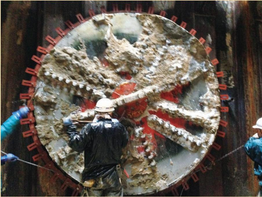
貯留管推進工事・推進機到達時の状況写真です。長距離推進の為に到達立坑への到達不安や到達に伴う出水不安が無くなり安堵している時の写真です。
