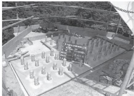
図-5 補強材（プレート）設置完了
