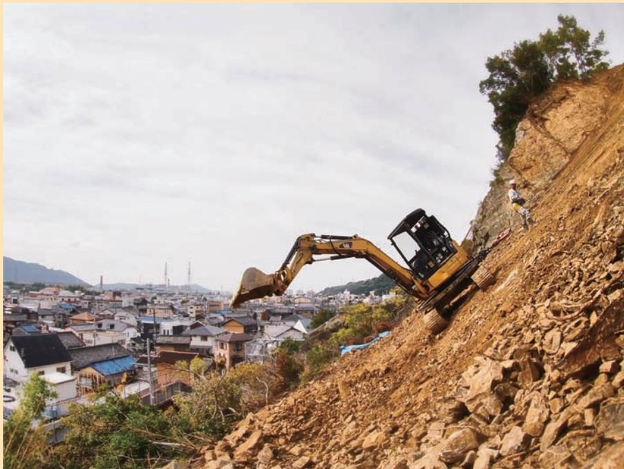
夏の豪雨で斜面が崩れ、土砂が民家に迫ってきました。バックホウは、斜面にワイヤーロープでぶら下がって動いています。無線操縦の無人機ですが、操縦者も少し離れてぶら下がって、懸命に土砂を撤去しました。(講評) 遠くの鉄塔が垂直なのに右半分はなんとシュールな画像でしょう! バックホウのバケットの角度とオベの振り向き具合が何とも言えません。臨場感と緊張感とで画面構成などどうでもいらい立派な作品に仕上がっています。空の雲が黒かったりするとそりゃもう完璧ですね。(土木写真家 西山芳一氏)
