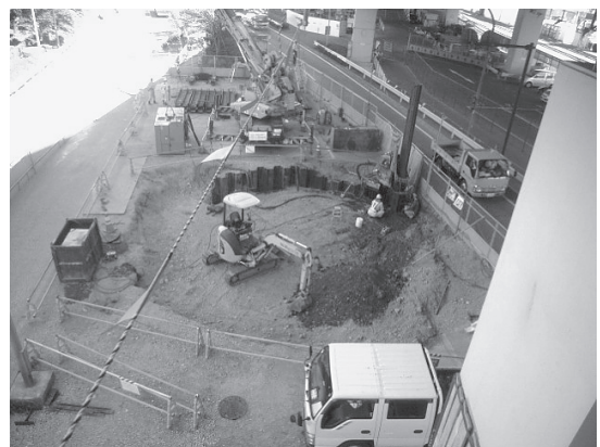
図-2 中央分離帯での施工状況
