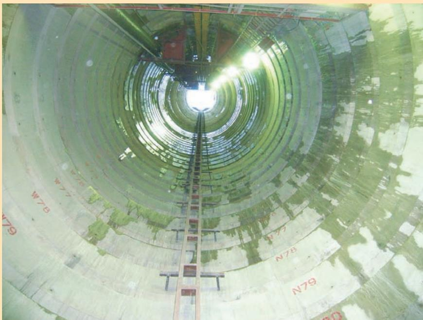
工事内容：地滑り対策工において深礎径 $\phi$ 6.5m深さ86mの抑止杭工の築造工事
