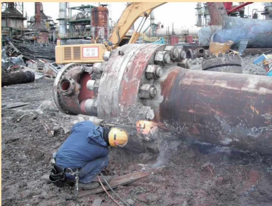
設備解体工事で発生した機器を母材が肉厚のため機械では切断できない。そこで、熟練工の腕を頼りにガス切断して解体している写真です。文字通り、暑い日も寒い日も黙々と安全に気を付けながらいつも頑張ってくれている職人さんです。
