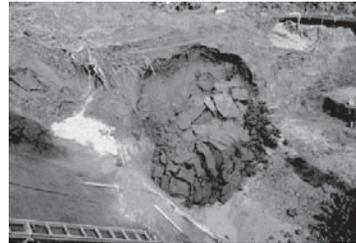
写真-1 堰堤掘削箇所地滑り状況
