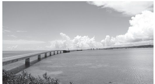
「伊良部大橋」(平成27年1月開通予定) 宮古島と伊良部島を結ぶ橋。延長6,500メートル、本橋部3,540メートルで、無料で通行できる橋としては日本最長。
