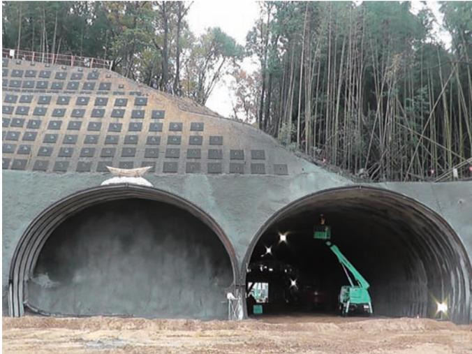
大阪府河内長野市で施工された、支保工吹付け間84ミリの超近接めがねトンネルです。右側の先行トンネル掘削時に1度目のゆるみ、左側の後行トンネル掘削時に2度目のゆるみ。中央部の地盤改良、全線にわたる長尺鋼管先受工、鏡吹付工および吹付けインパートの効果で、大きな崩落や変位を受けることなく、完成しました。この写真がまさに、超近接めがねです。
