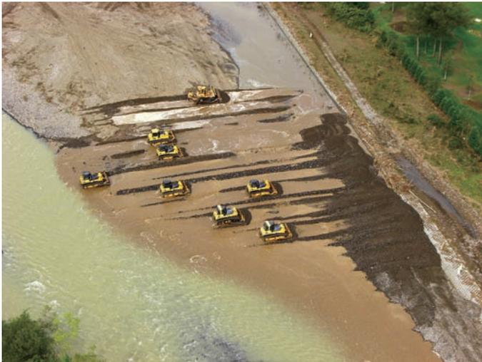
北海道河東郡音更町で平成23年9月の台風による大雨で音更川が堤防決壊し、緊急復旧工事をおこなったときの写真です。緊急復旧ということもあり、ブルドーザーを一斉に稼働させました。ブルドーザーは、土木工事には欠かせない機械です。上空からの撮影なので、本当は大きなブルもまるでチョロQを走らせているかのように写っています。町民が一日も早く安心できるように、すばやく対応をしました。数台のブルが並んで作業することは多くないので、この機会に上空から撮影し投稿してみました。
