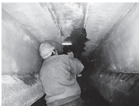
図-8 表面被覆工
