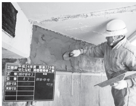
図-6 断面補修工（左官作業）
