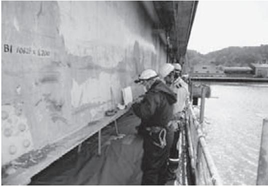
図-2 主桁損傷の調査状況
