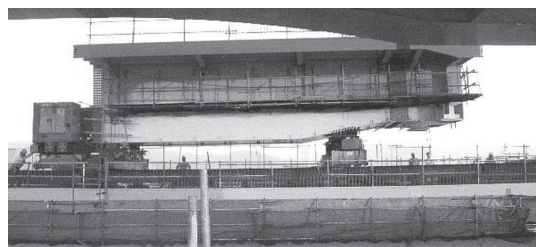
図-9 縦取り軌条設備・ランプ部鋼桁運搬状況
