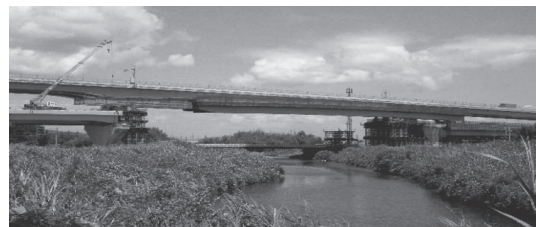
図-4 寺川橋/一般部(下り線) 送出し架設状況
