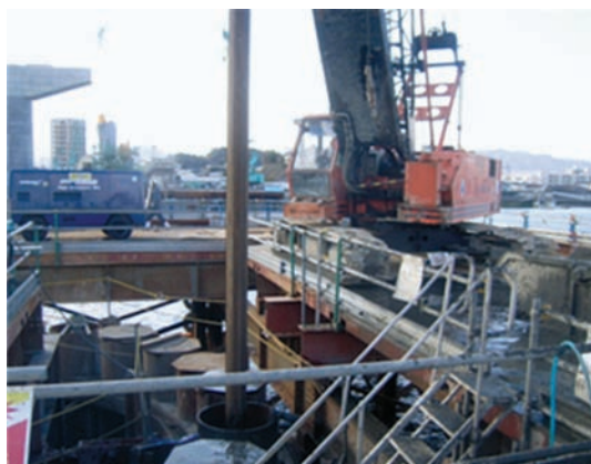
アースドリル施工状況
