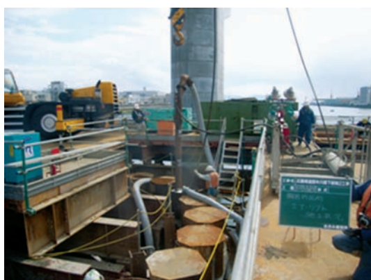
エアーリフト施工状況
