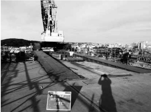
図-6 クレーン用スロープ架台
