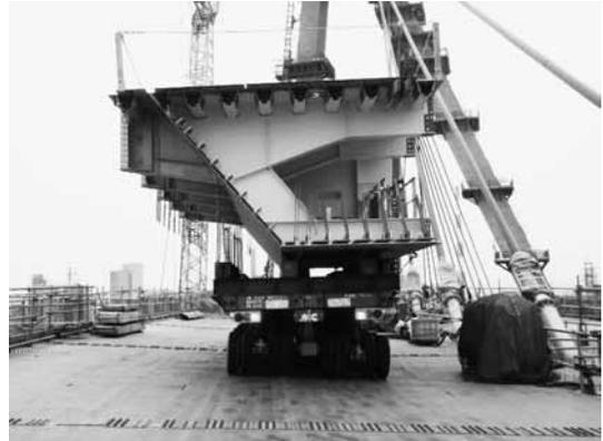
図-7 鋼桁運搬状況（外セル）
