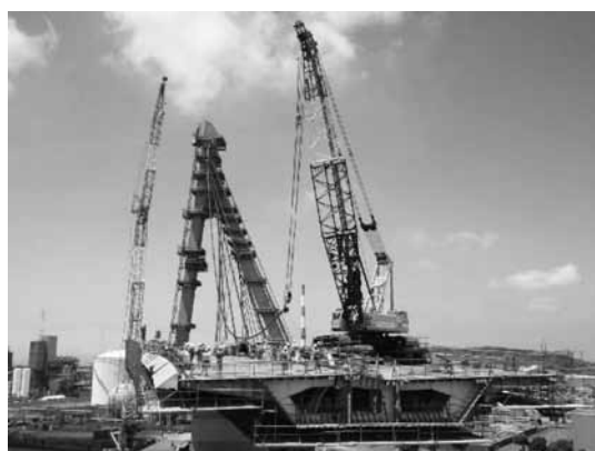
図－３ 施工状況（ケーブル保護管）
