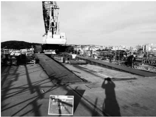
図－６ クレーン用スロープ架台
