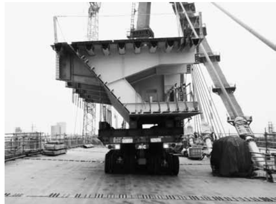
図－７ 鋼桁運搬状況（外セル）
