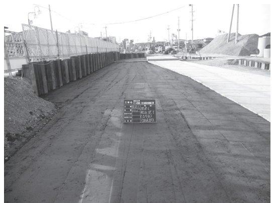
図－3 付加土利用による路床盛土
