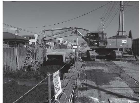
図－1 攪拌混合改良状況
