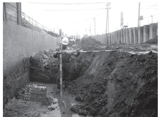
図－2 攪拌混合による付加土(残土)
