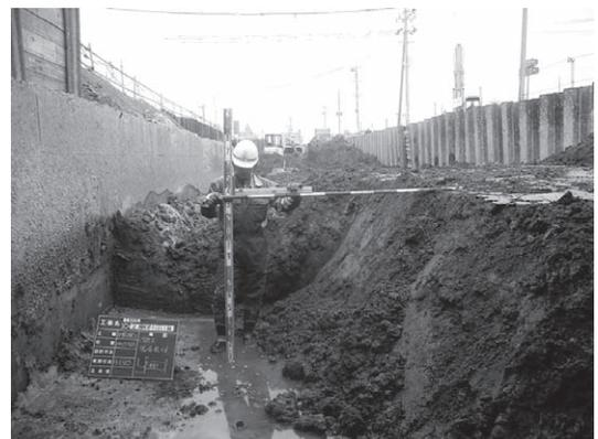
図-2 攪拌混合による付加土(残土)
