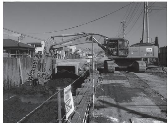
図-1 攪拌混合改良状況
