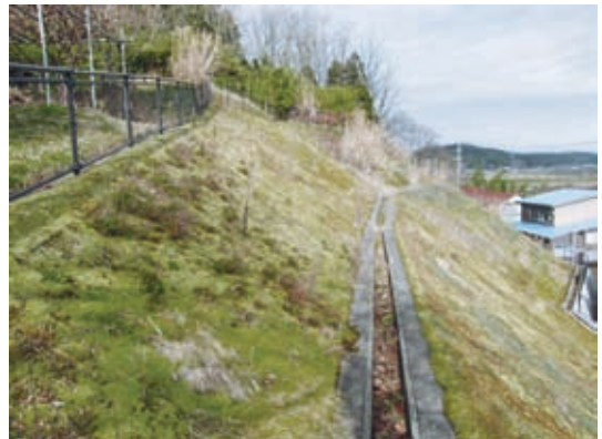
コケ緑化施工（施工後7年経過）
