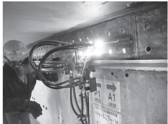
図-4 ガス切断状況
