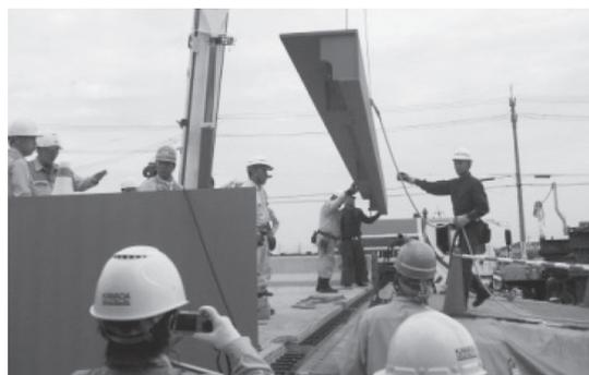
図-13 仮設鋼床版架設 (模擬訓練)
