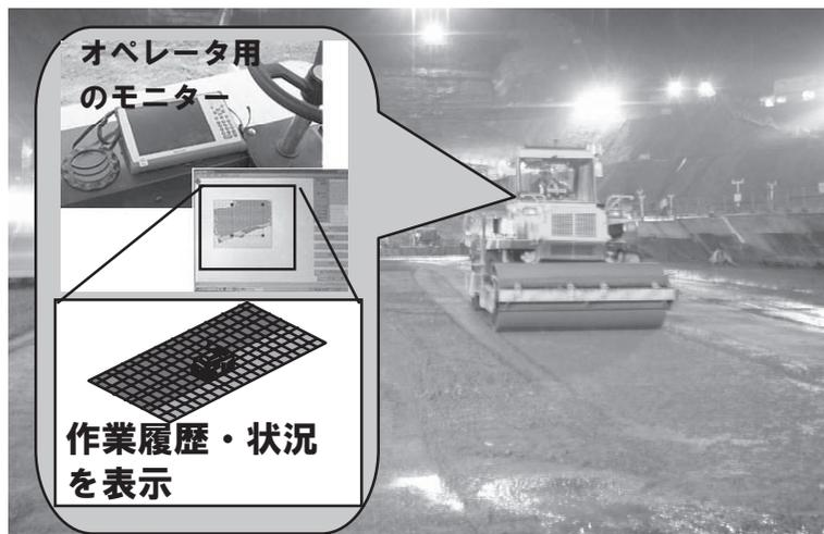
図4 TS・GNSS締固め
