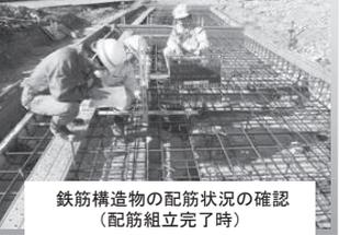
鉄筋構造物の配筋状況の確認
