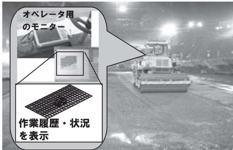
図4 TS・GNSS締固め
