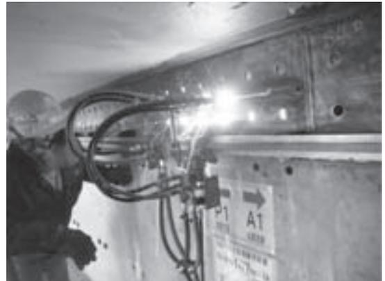
図-4 ガス切断状況
