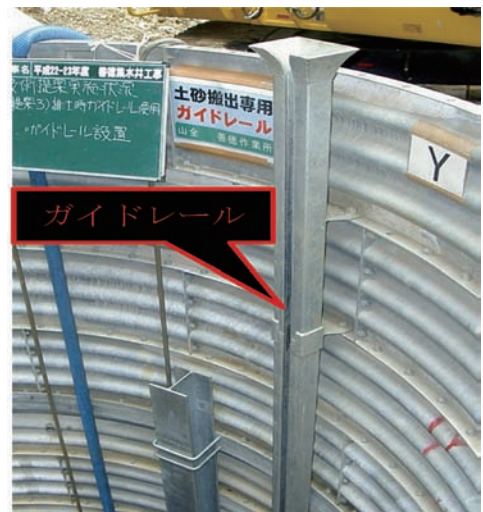
ガイドレール取付状況
