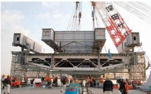
図-5 併合部箱桁の大ブロック架設（断面）
