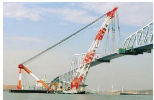
図-4 併合部箱桁の大ブロック架設（側面）
