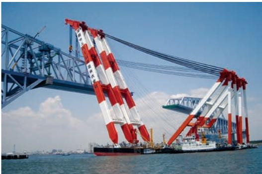
図-3 トラス部大ブロック架設
